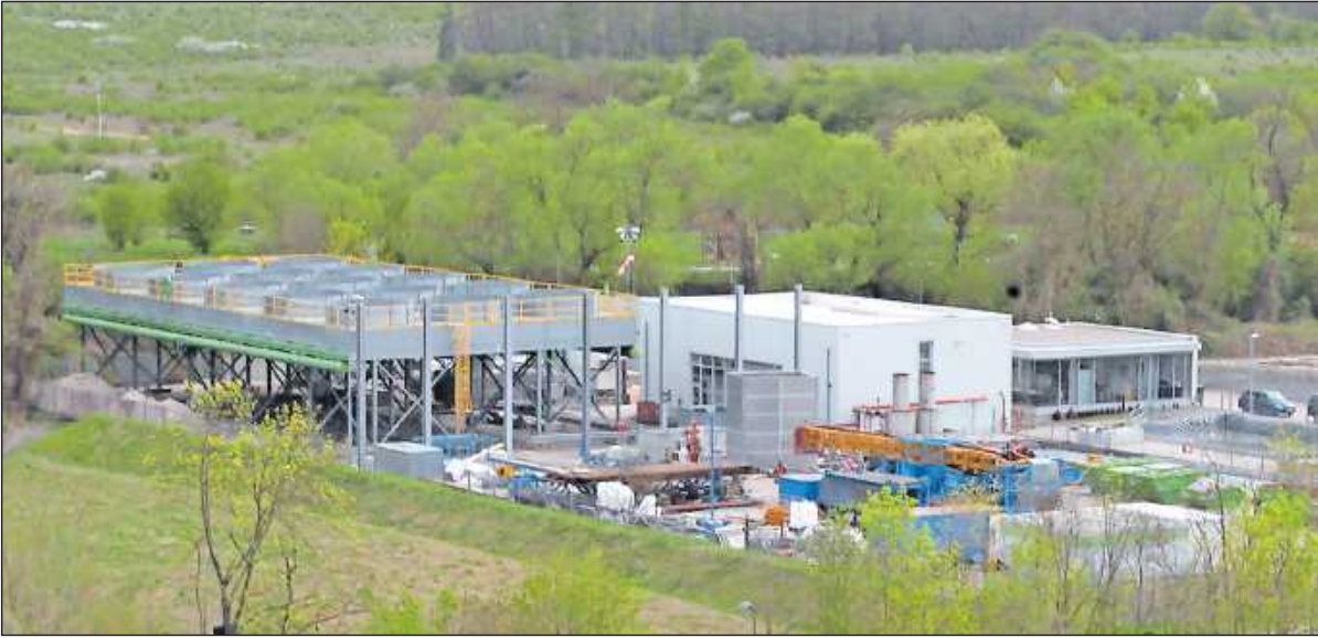
Die Lustadter Bürger dürfen darüber entscheiden, ob sie ein Geothermiekraftwerk auf ihrer Gemarkung wollen. Die Anlage auf dem Bild steht in Landau. ARCHIVFOTO: VAN
